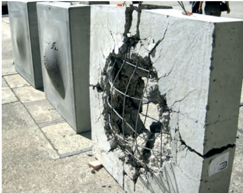
Bild 2: Stahlbetonplatte mit Durchstanzung und Auswurf nach Detonationsbelastung [11]
